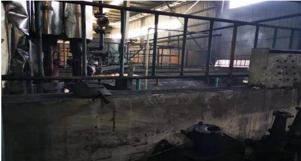
图 4-16 焦油储罐 1.5m 防护围堤
