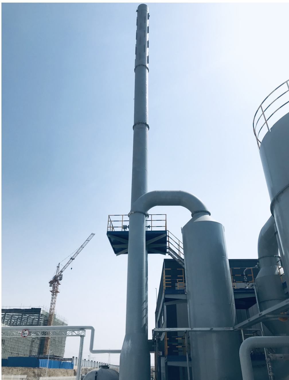
图 1-1 旋转式蓄热氧化炉排放烟囱
